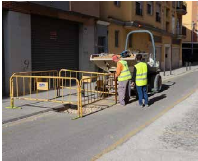
Actuaciones en Torrent. / EPDA
